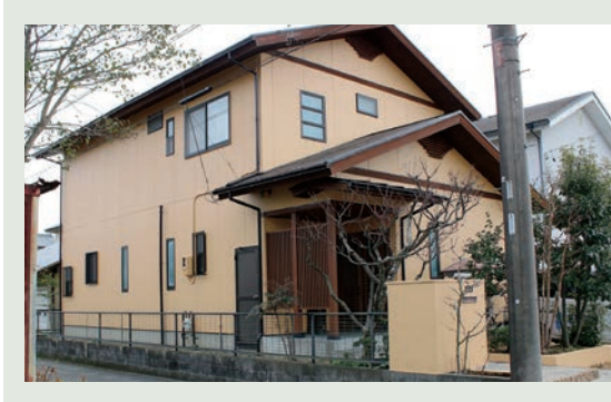
築22年 藤枝市 M様 外壁・屋根塗装 施工
