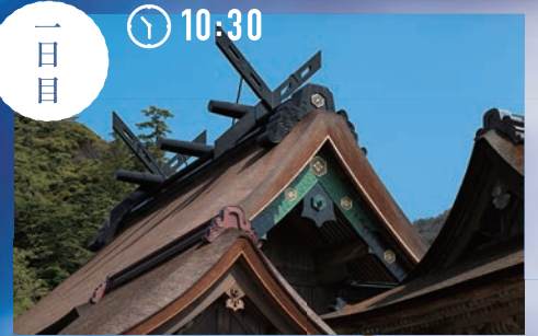
▲本殿（国宝） 大社造りと呼ばれる日本最古の神社建築様式の御本殿
